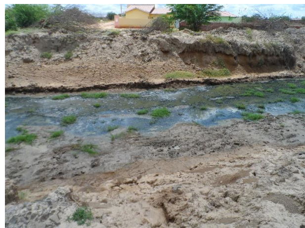
Fig. 12 – Erosão na margem e assoreamento do rio sem mata ciliar. Foto: Lucíola Cordeiro.
