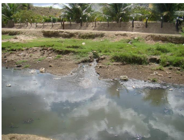
Fig. 15 – Lançamento de esgoto no rio. Foto: Lucíola Cordeiro.
